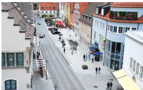
Příklad vhodného řešení zastávky veřejné dopravy ve sdíleném prostoru. Zřízení nástupní hrany je jedinou výjimkou z pravidla jedné výškové úrovně. Z ostatních stran nástupiště plynule navazuje na okolní prostor; zdroj: Cit.3
