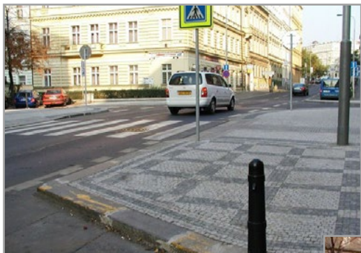
Rekonstrukce křižovatky Rumunská x Londýnská (ZŠ Londýnská, projekt v r. 2004, realizace 2006)
