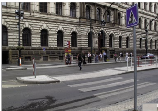
Rekonstrukce tramvajových zastávek u Národního divadla – stavební úpravy přechodů, vyčkávací ostrůvky (ZŠ sv. Vršily projekt v r. 2007, realizace 2011)
