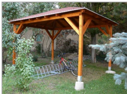
Přístřešek na kola, ZŠ Písnice (2011)
